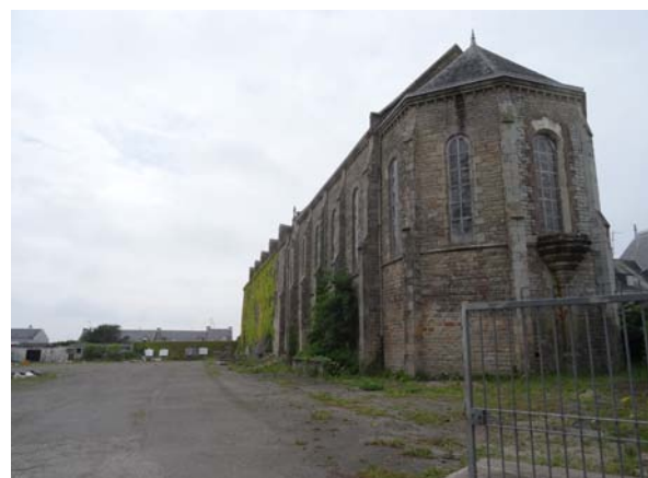
Vue du Petit Séminaire depuis le Nord-Est.
