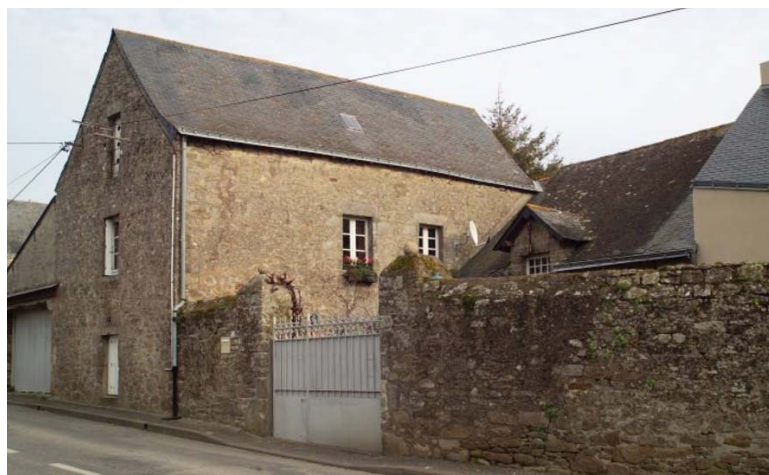
Ancienne ferme vue de la rue. Source : Inventaire de la Région Pays
